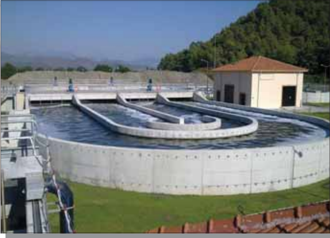
Ortaca AAT, 6x37 kW (frekans invertörlü)
