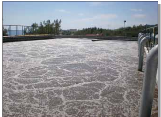
Blower-difüzör, Belek II AAT, 2x3000 m 3 /hr
