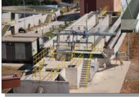
Havalandırılmalı Kum ve Yağ Tutucu
