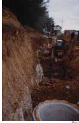
Betonarme Boru Kollektör İnşaatı
