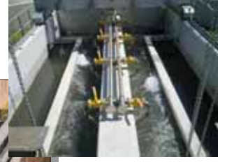
Havalandırılmalı Kum ve Yağ Tutucu
