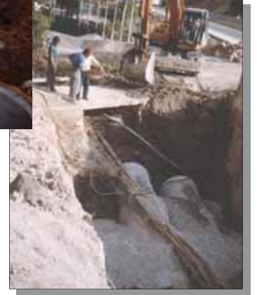
Betonarme Boru Kollektör İnşaatı
