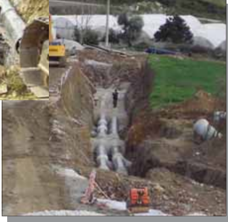
HDPE Terfi Hattı İnşaatı
