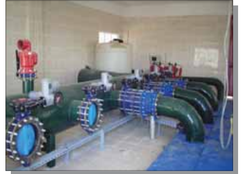
Pompa İstasyonu İnşaatı
